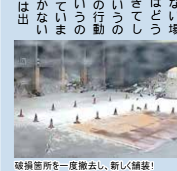
破損箇所を一度撤去し、新しく舗装！
