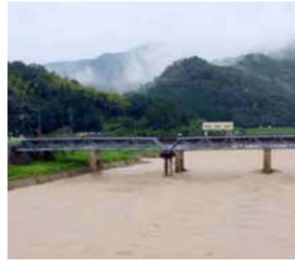
川の水位も上がり、大変危険な状況でした。
